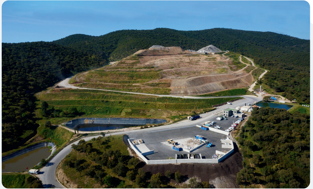
Casier déchets (Pierrefeu du Var 83390) Site en exploitation
