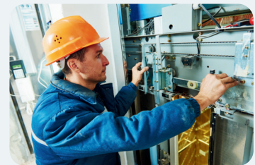
Techniciens de maintenance
