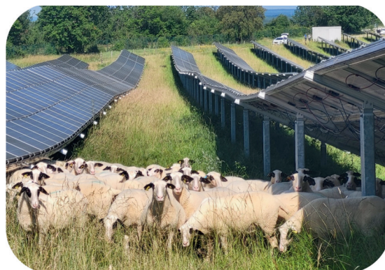
Centrale VALECO dans le Lot (46)
